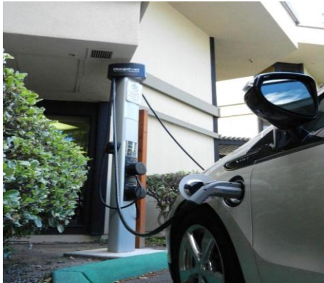
ب) ایستگاه شارژ عمودی با کابل جمع شونده
